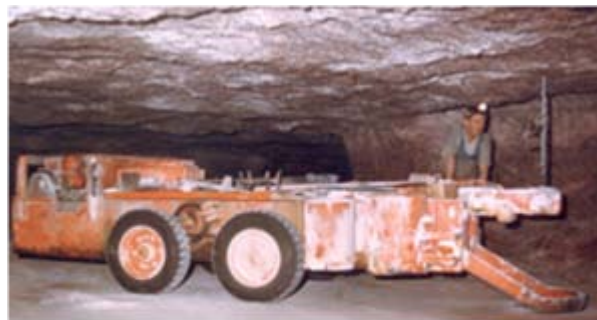
鉱坑の天井を強化するためにボルトを打ち込むディーゼル・エンジン機械
